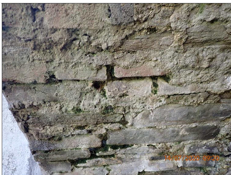
08.Degradace betonu a průsak na nosné konstrukci.JPG
