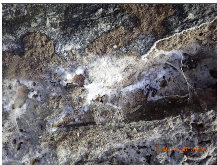
09.Vápenné výluhy na nosné konstrukci.JPG
