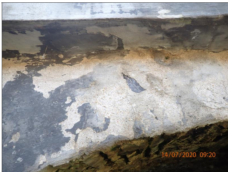
05.Degradace betonu čela a římsy vlevo.JPG
