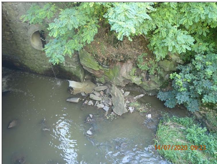
13.Poškozená stěna koryta vpravo.JPG
