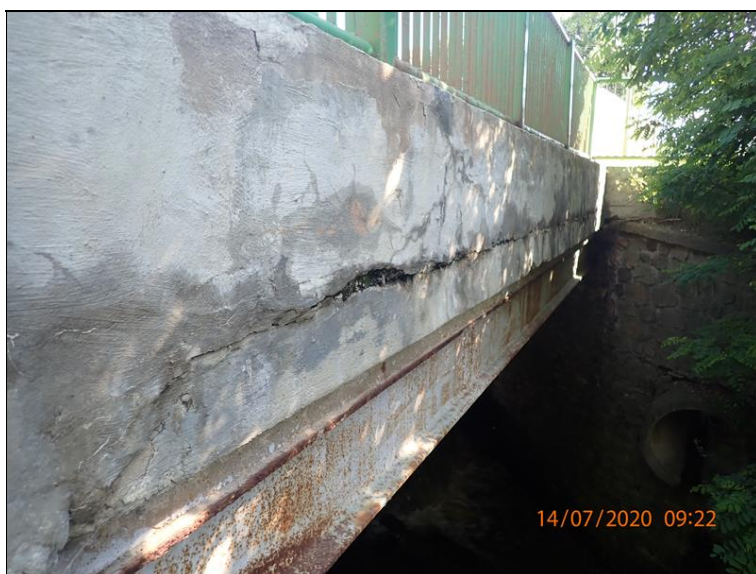
12.Podélná trhlina na římse vpravo.JPG
